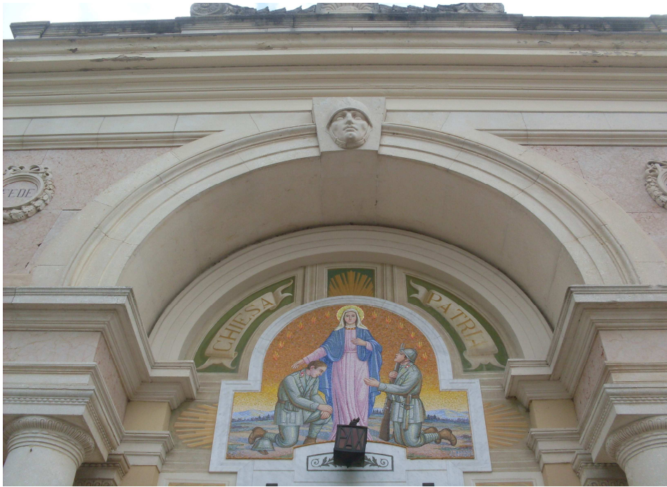
(Particolare della facciata con le pitture di L.Nasato)
