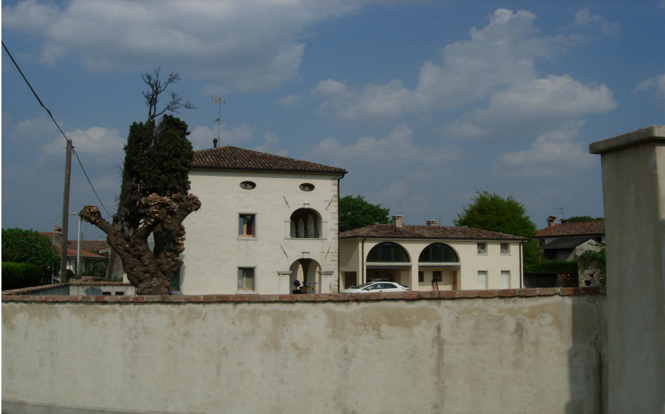
Casa Partili vista da via Rive
